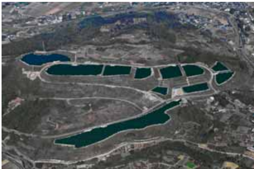
米倉山メガソーラー発電所
