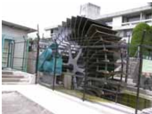
家 みちのう 中川小水力市民発電所「元気くん1号」(写真提供: 都留市)
