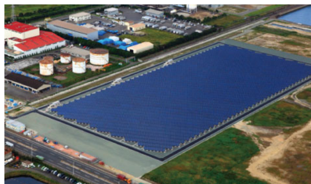
福山太陽光発電所：中国電力(株)提供
