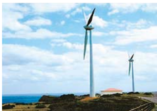
風力発電設備（与那国島）
