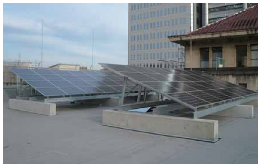
県庁本館に設置した太陽光発電パネル
