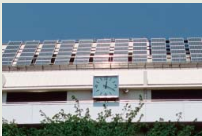
中央区保健所の太陽光発電パネル
